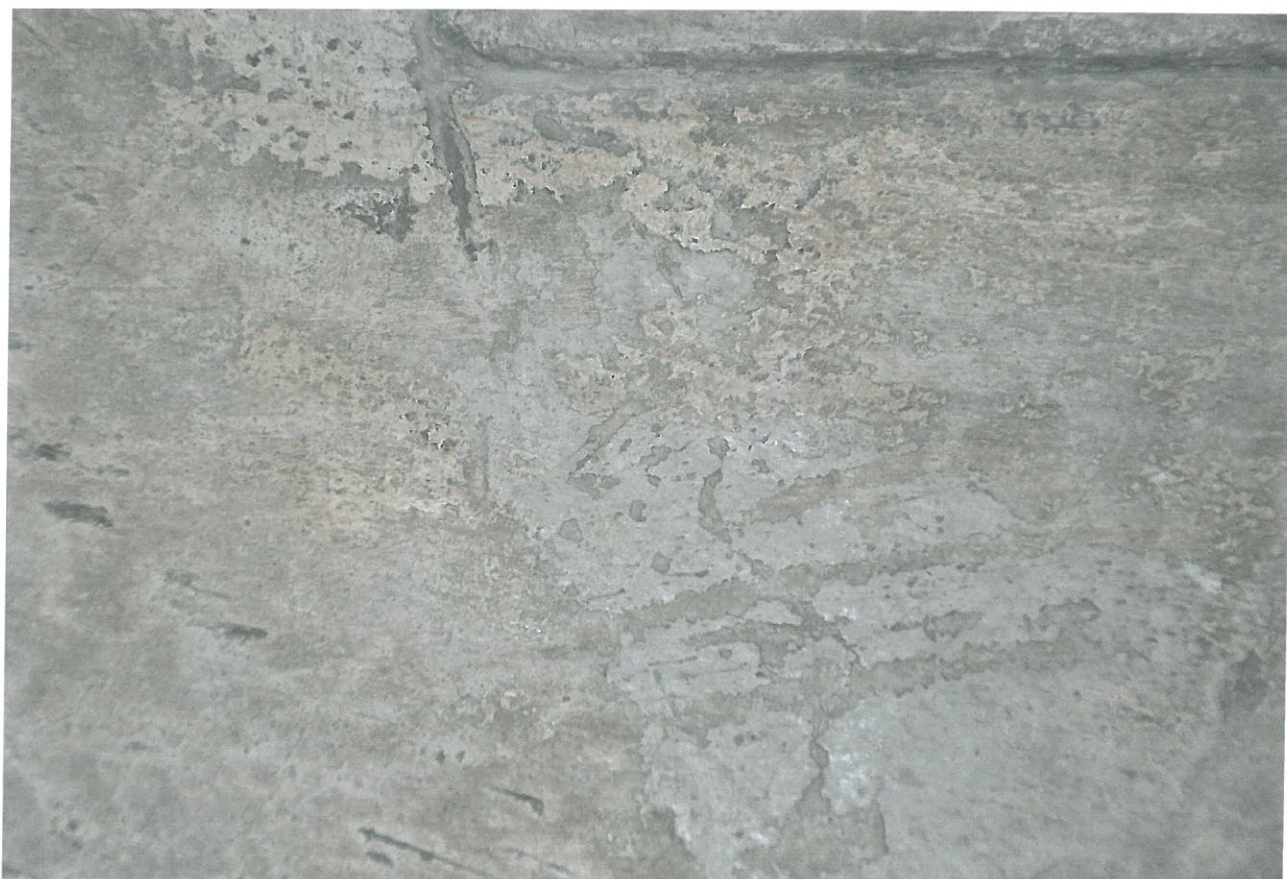
Fot. nr 25. Odkrywka stratygraficzna na ścianie wschodniej (tło) z zachowanym reliktem pierwotnego opracowania kolorystycznego tła dekoracji sztukatorskiej w kolorze perłowym.
