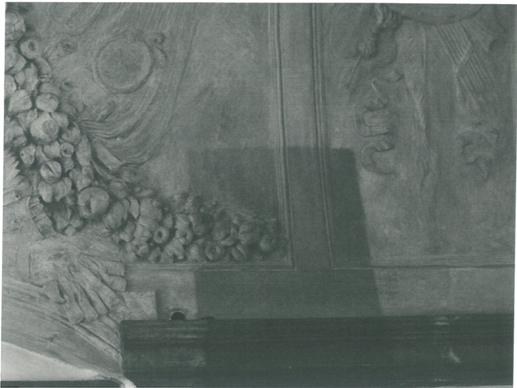
Fot. nr 42 i 43. Stan w trakcie konserwacji. Na zdjęciach etap w trakcie czyszczenia sztukaterii.
