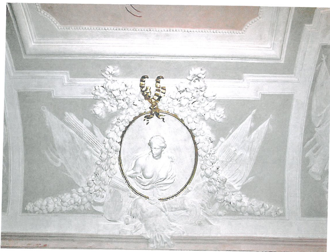
Fot. nr 59 i 60. Odtwarzanie kolorystyki dekoracji sztukatorskiej gabinetu i rekonstrukcja złoceń.
