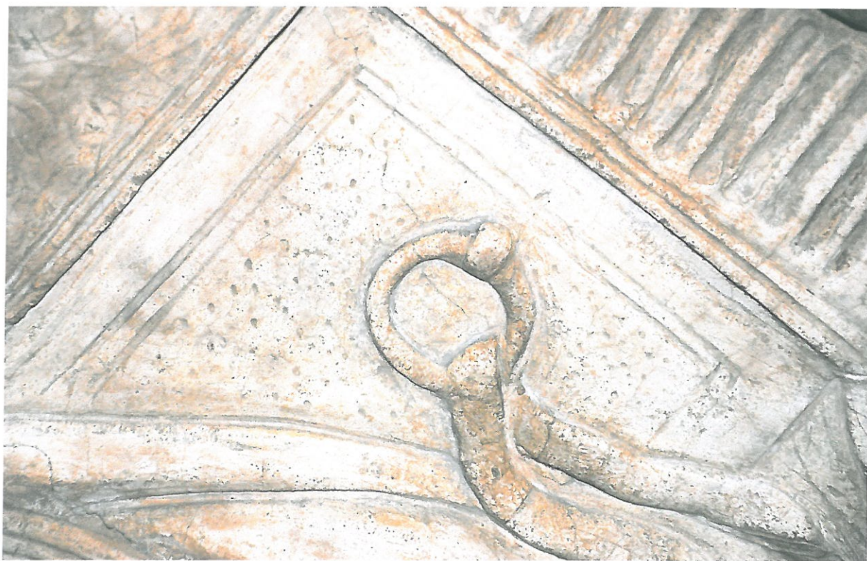
Fot. nr 26 i 27. Odkrywki stratygraficzne na elementach rzeźbiarskich. Widoczne pierwotne opracowanie dekoracji w kolorze białym.
