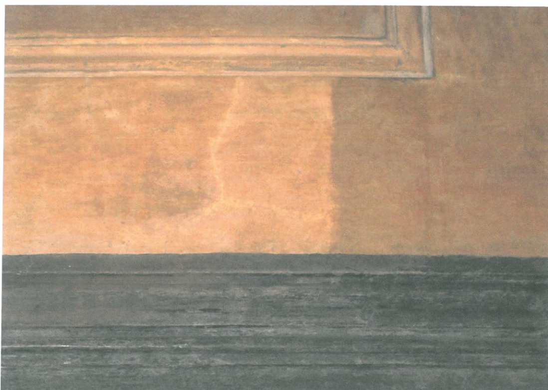
Fot. nr 44 i 45. Stan w trakcie konserwacji.
