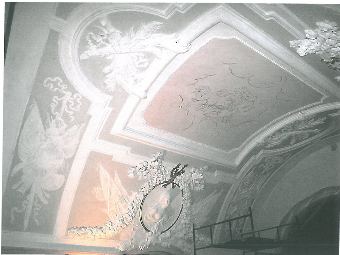
Fot. nr 61, 62 i 63. Stan po konserwacji i odtworzeniu kolorystyki i złóceń.
