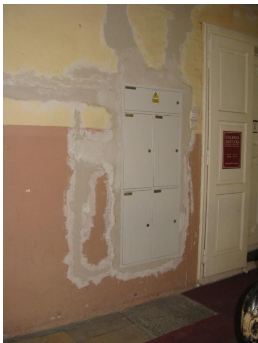
Klatka schodowa – widoczna nowa instalacja elektryczna i przemurowania tynku.
