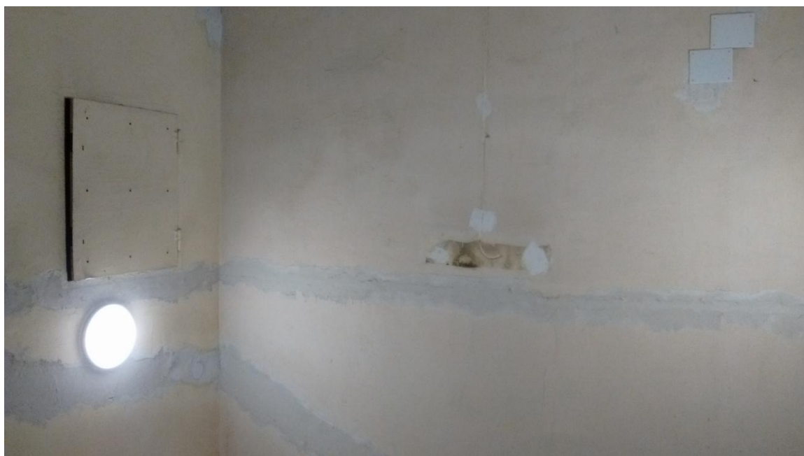
Klatka schodowa - widoczne skrzynki instalacyjne i przemurowania.
