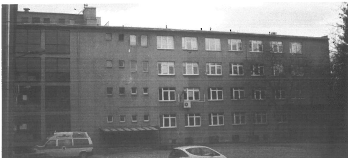
Fot. 6. Kraków, Szwedzka 27 – segment I ściana południowo-zachodnia budynku.
