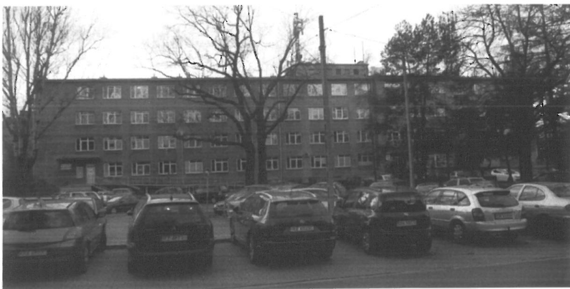
Fig. 3. Kraków, Szwedzka 27, ściana północna budynku.
