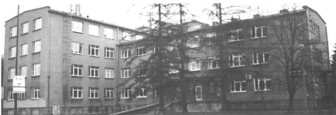
Fot. 4. Kraków, Szwedzka 27 – segmenty I i II ściany północno-zachodnie i południowo-zachodnie.
