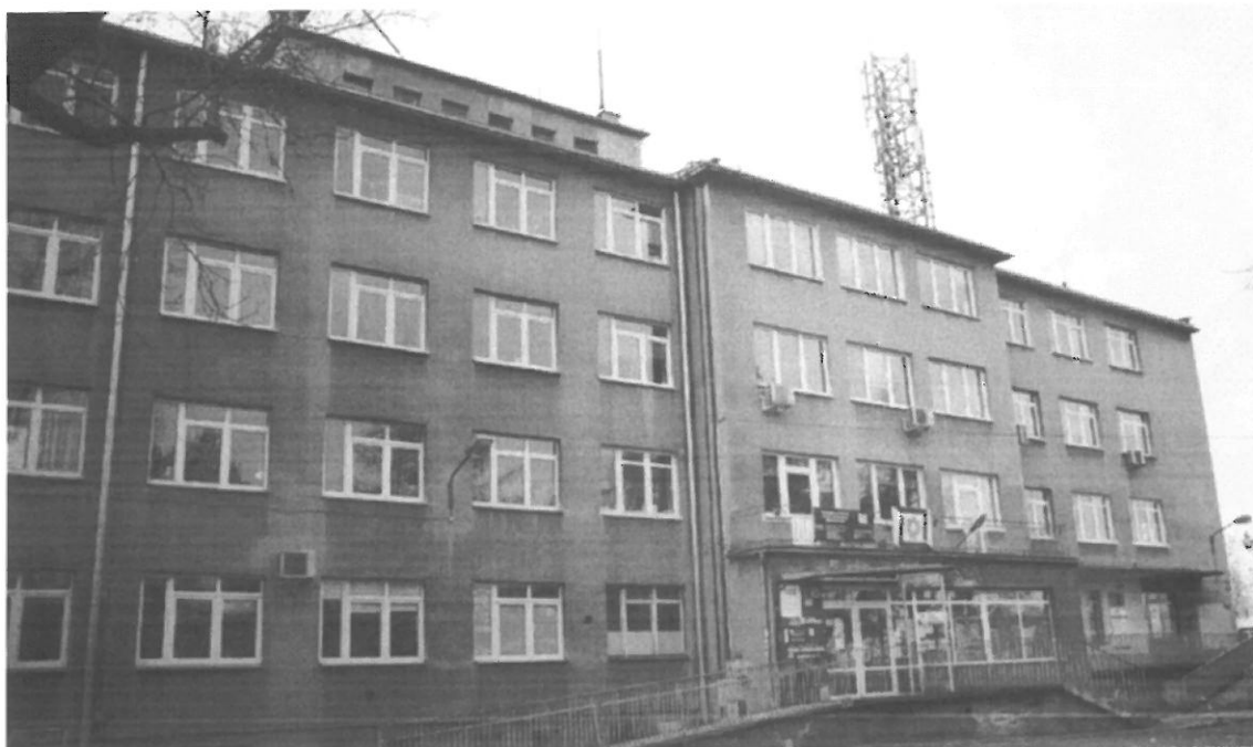
Fot. 2. Kraków, Szwedzka 27 – ściana północno-wschodnia segmentu I budynku, część południowa.
