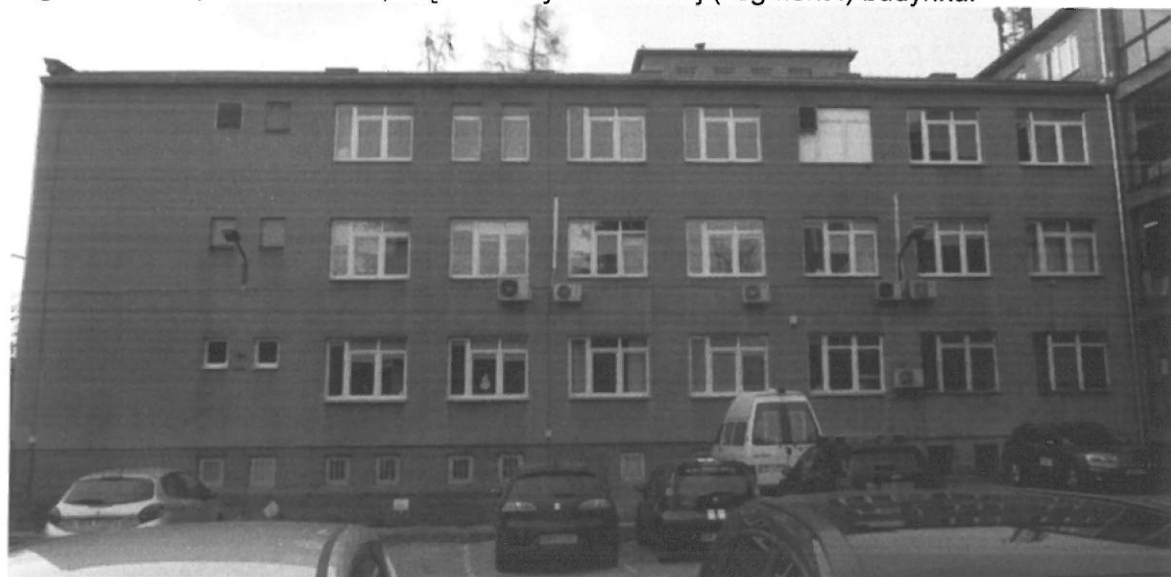
Fig. 5. Kraków, Szwedzka 27, ściana wschodnia budynku (segment II).
