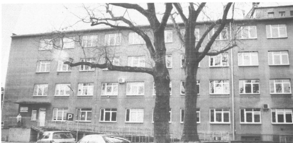
Fot. 3. Kraków, Szwedzka 27 – ściana północno-wschodnia segmentu I budynku, część północna.
