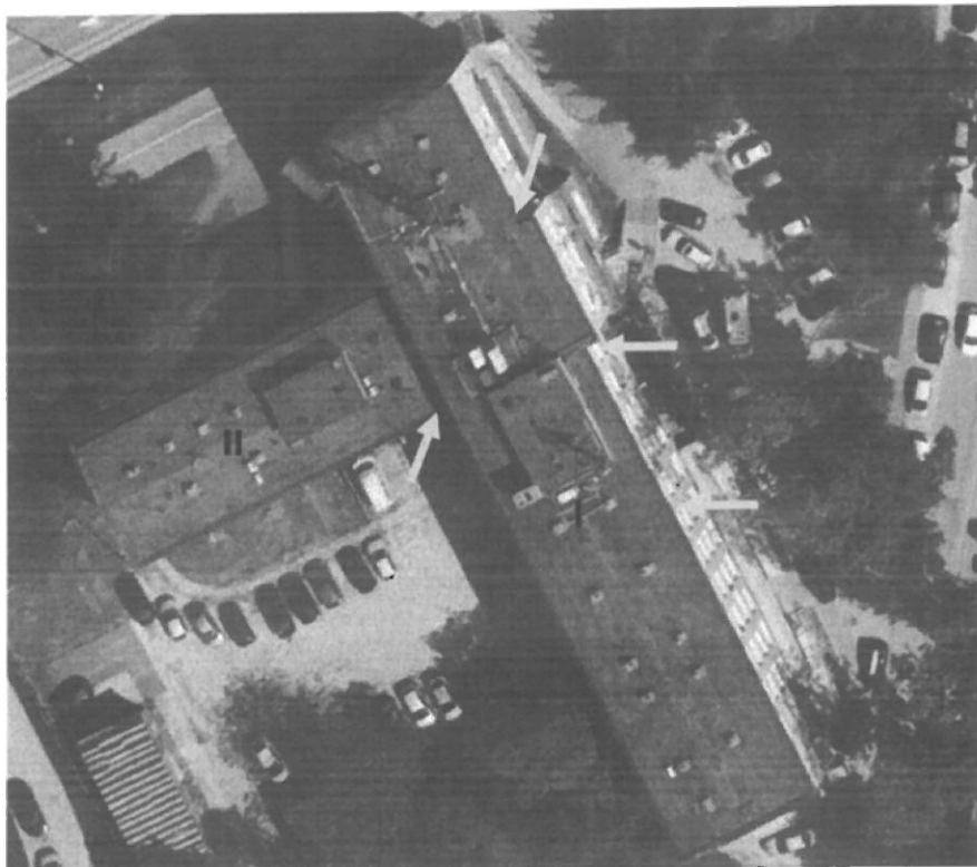
Fot. 7. Kraków, Szwedzka 27 – wskazano miejsce w którym rury spustowe przechodzą przez okap dach, gdzie znajdują się potencjalne siedliska jerzyka.
