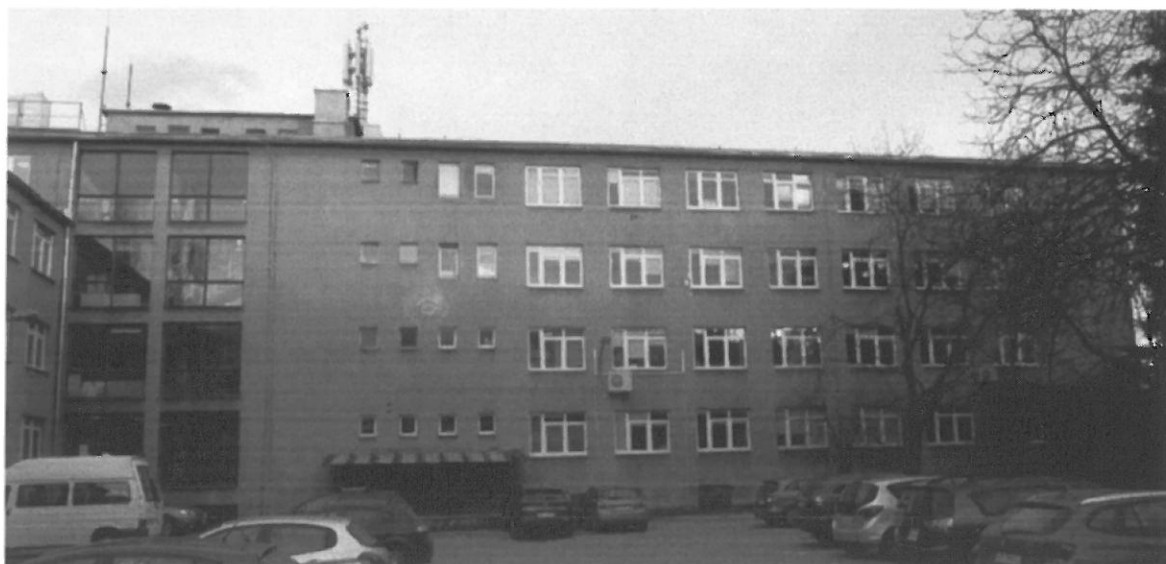
Fig. 6. Kraków, Szwedzka 27, ściana południowa budynku (segment II).
