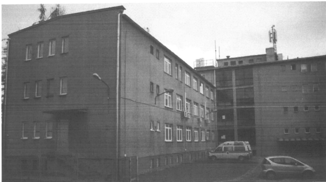
Fot. 5. Kraków, Szwedzka 27 – segment I ściana południowo-zachodnia i południowo-wschodnia oraz segment II - ściana południowo-zachodnia.
