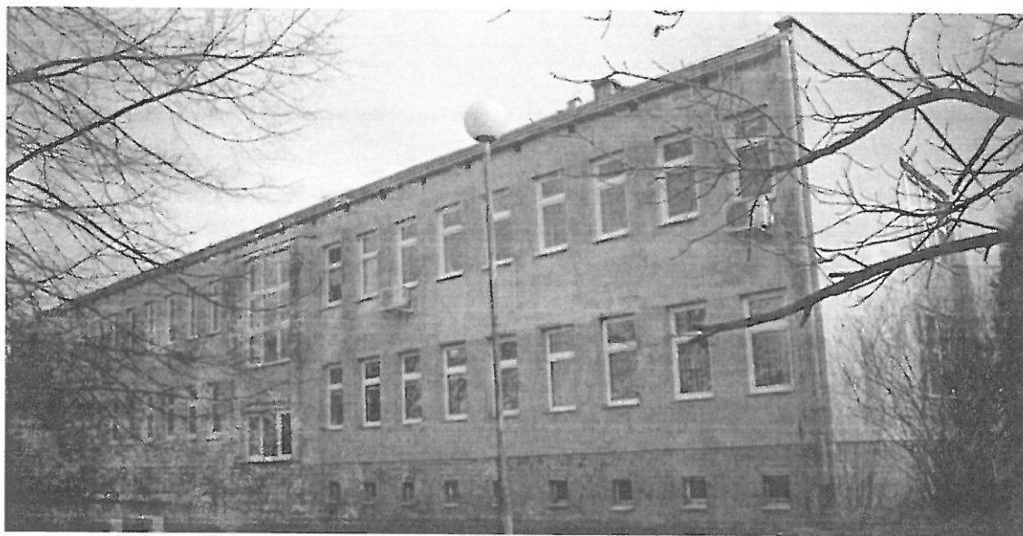
Fot. 3. Kraków, Heleny 2 – ściana zachodnia i południowa budynku.
