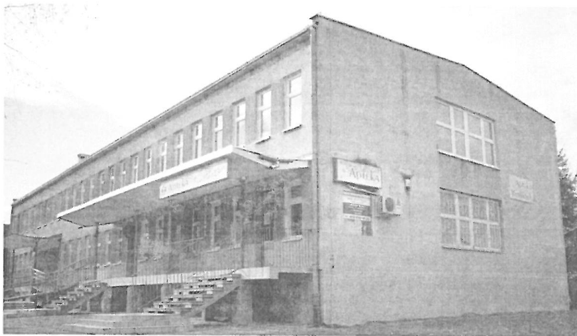
Fot. 2. Kraków, Heleny 2 – ściana wschodnia i północna budynku.
