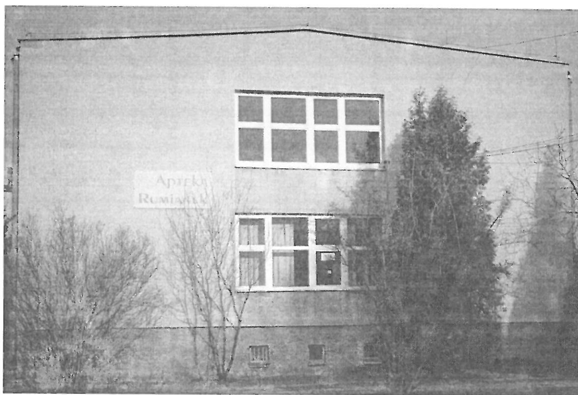
Fot. 4. Kraków, Heleny 2 – ściana południowa budynku.
