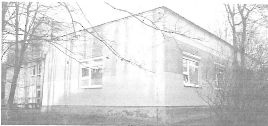
Fot. 5. Kraków, Os. Na Wzgórzach 1 – segment I i II ściana południowo-zachodnia budynku, segment II ściana południowo-wschodnia.
