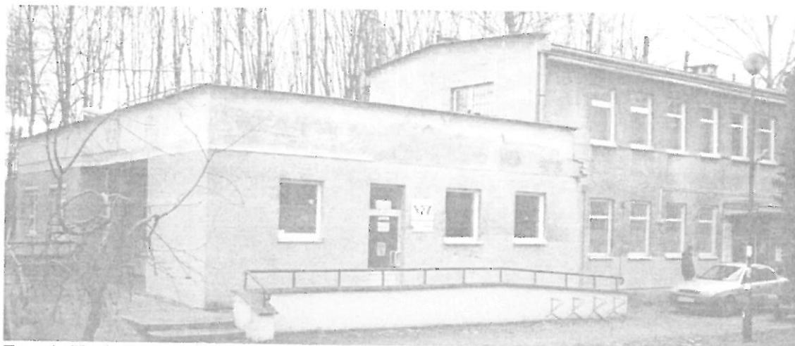
Fot. 4. Kraków, Os. Na Wzgórzach 1 – segment I i II ściana południowo-wschodnia i północno-wschodnia.
