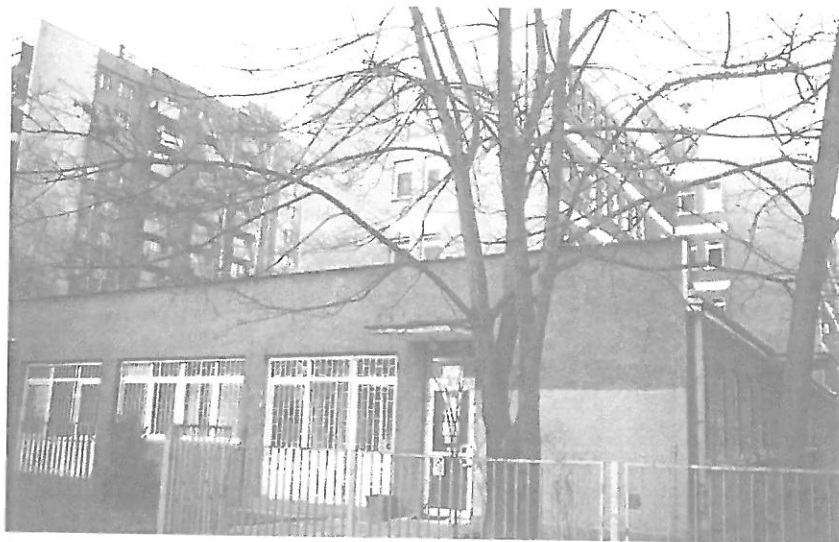
Fot. 8. Kraków, Rusznikarska 17 – ściana południowa I, II i III segmentu budynku oraz ściana wschodnia II segmentu budynku.
