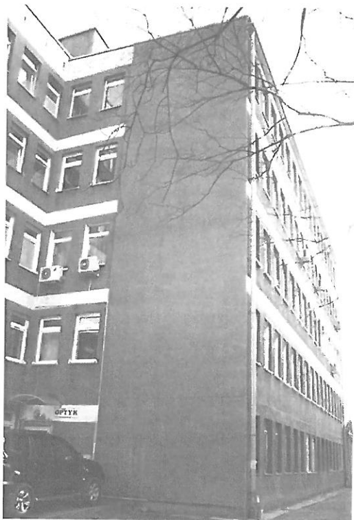
Fot. 5. Kraków, Rusznikarska 17 – ściana północna i wschodnia II segmentu budynku.
