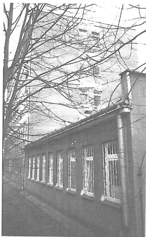
Fot. 6. Kraków, Rusznikarska 17 – ściana południowa II segmentu budynku oraz ściana zachodnia segmentu III budynku.
