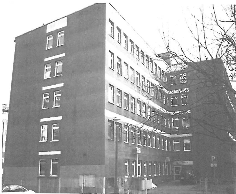
Fot. 4. Kraków, Rusznikarska 17 – ściana północna i zachodnia I segmentu budynku oraz ściana północna II segmentu budynku.
