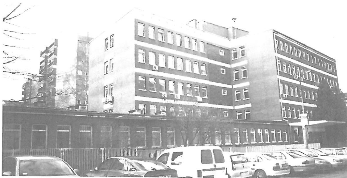
Fot. 2. Kraków, Rusznikarska 17 – ściana zachodnia I, II i III segmentu budynku oraz ściana południowa I i II segmentu budynku
