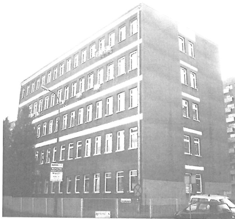
Fot. 3. Kraków, Rusznikarska 17 – ściana wschodnia i północna I segmentu budynku.
