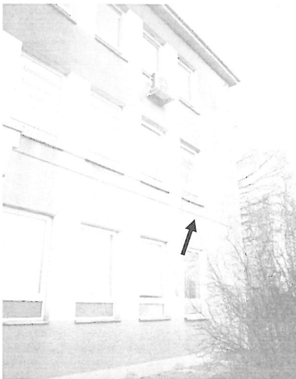
Fot. 5. Kraków, Al. Pokoju 4 – ściana południowo-wschodnia budynku, część wschodnia. Wskazano strzałką miejsce w którym pod blaszanym parapetem znajduje się otwór, potencjalne siedlisko jerzyka.
