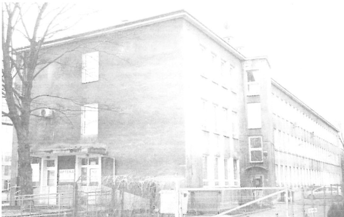
Fot. 4. Kraków, Al. Pokoju 4 – ściana północno-zachodnia i północno-wschodnia budynku.
