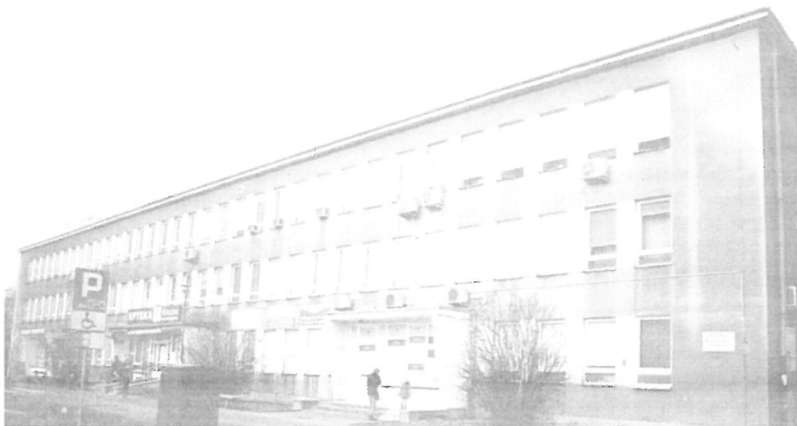
Fot. 2. Kraków, Al. Pokoju 4 – ściana południowo-wschodnia budynku.
