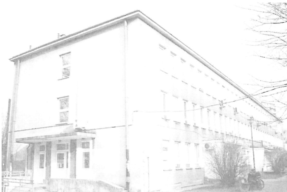
Fot. 3. Kraków, Al. Pokoju 4 – ściana południowo-zachodnia i południowo-wschodnia budynku.
