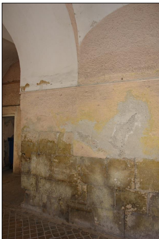
kapilarnego oraz zasolenia murów.
