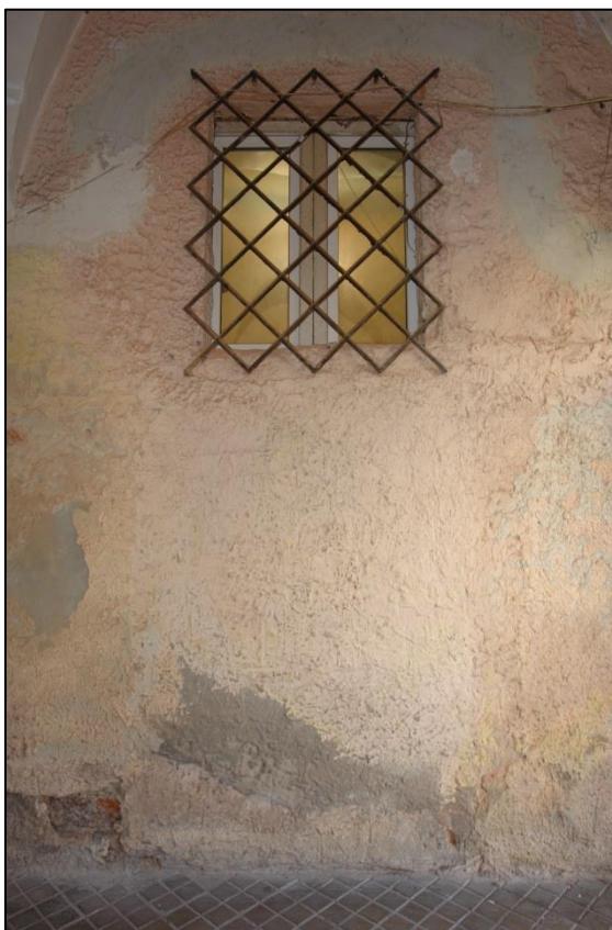
kapilarnego oraz zasolenia murów.
