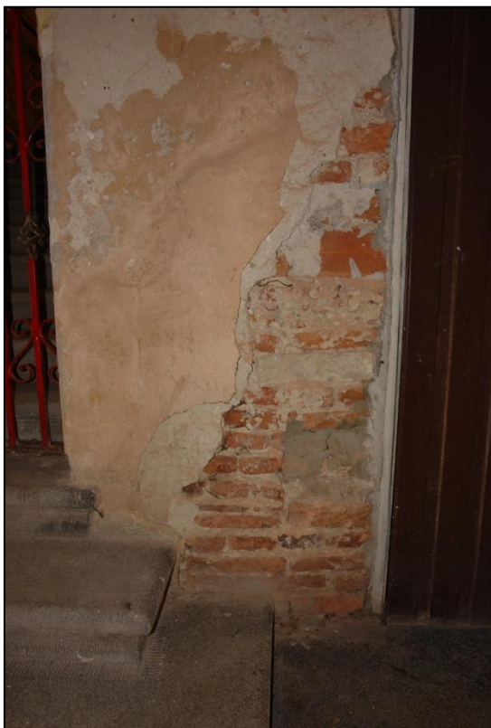
kapilarnego oraz zasolenia murów.
