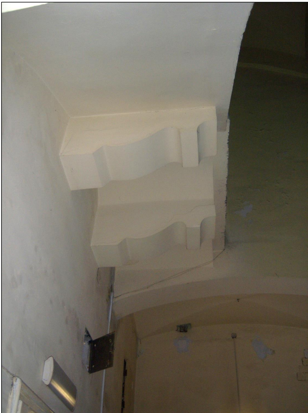
Klatka chodowa – wsporniki podestu II p.
