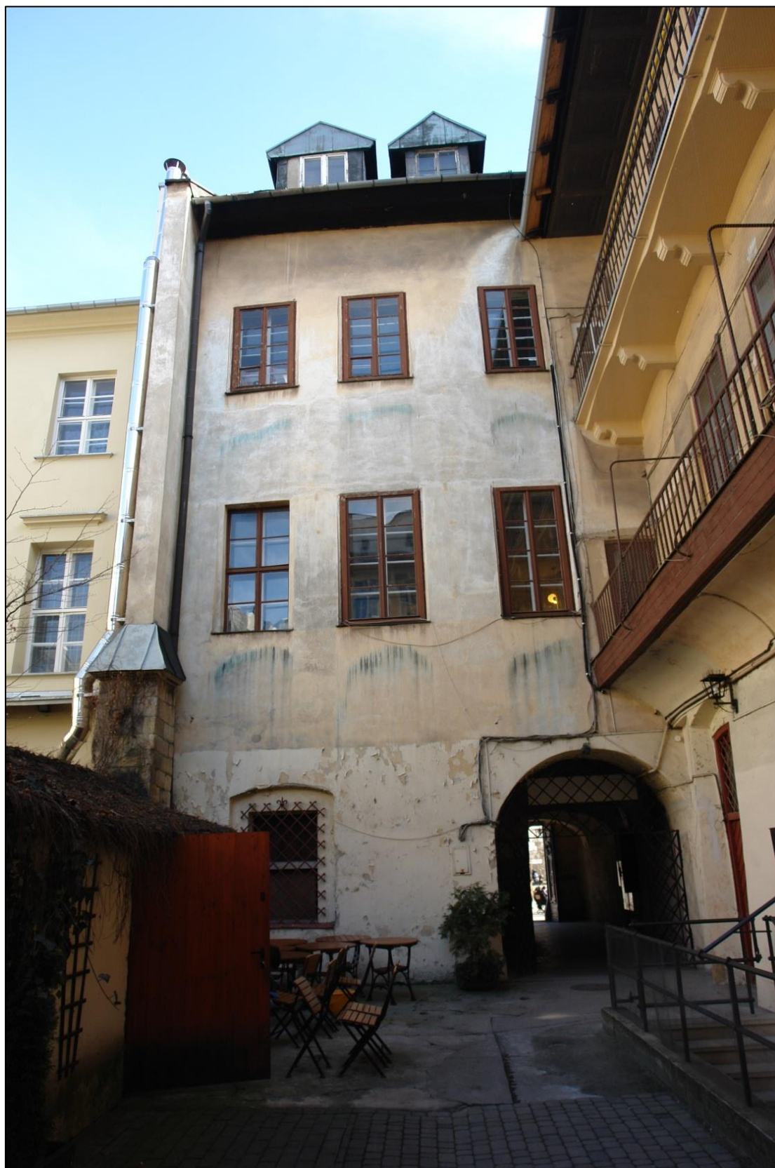
Elewacja tylna budynku frontowego.
