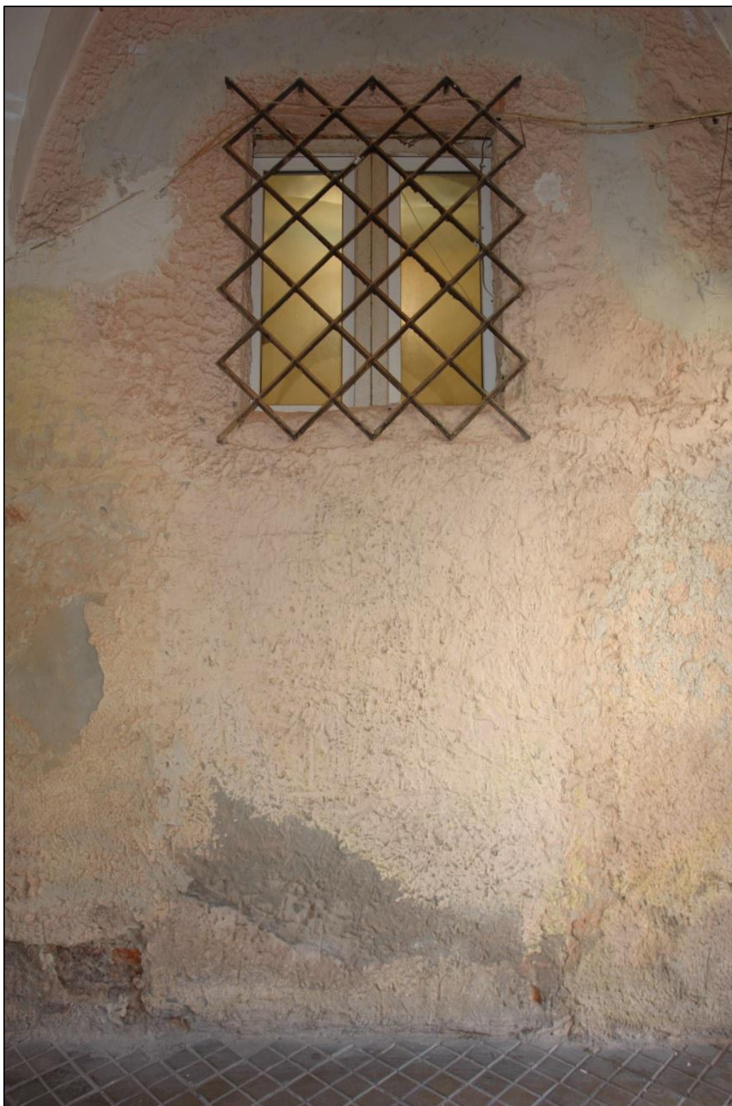
Sień – widoczny tynk fakturowy maskujący przemurowania, nowe okno plastikowe.
