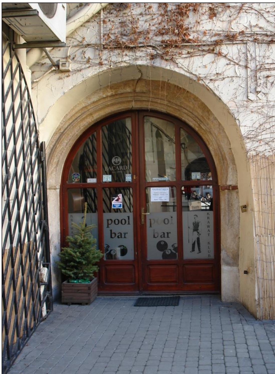
Elewacja oficyny tylnej – widoczny portal wejściowy z wapienia, nowa stolarka. W dobrym stanie technicznym
