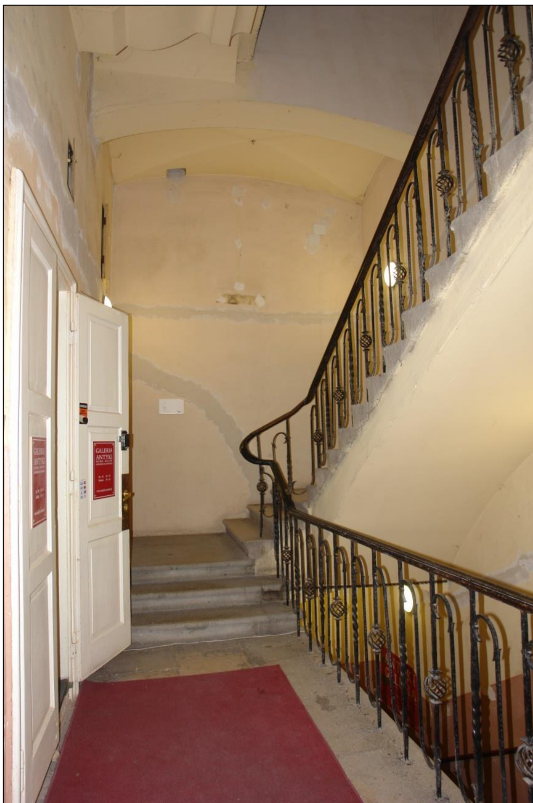
Klatka schodowa – widoczne przekucia oraz skrzyni instalacji elektrycznej.
