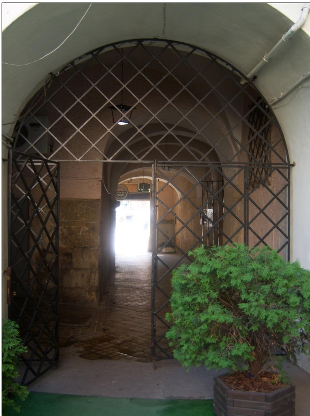
Widoczna niepierwotna krata stalowa zabezpieczająca wejście do budynku od strony podwórca.
