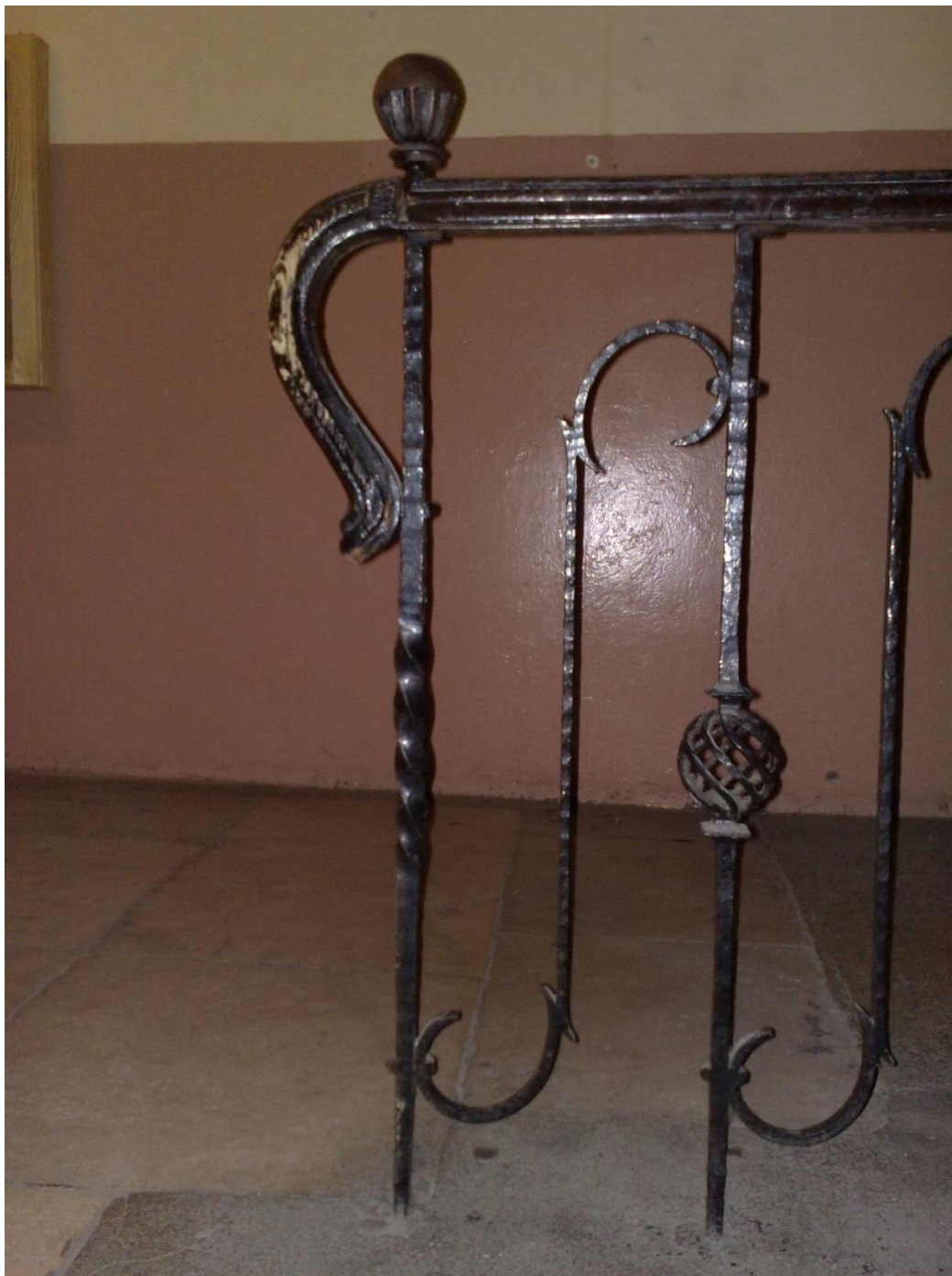
Klatka schodowa - Balustrada stalowa z drewnianym pochwytym.
