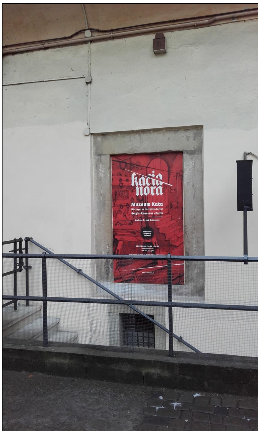
Elewacja oficyny bocznej – widoczne różne warstwy malarskie na tynku, zaślepiiony portal kamienny, nową metaloplastykę zejścia do piwnic oraz nowe schody w okładzinie kamiennej, nowa metaloplastyka balustrad i poręczy.
