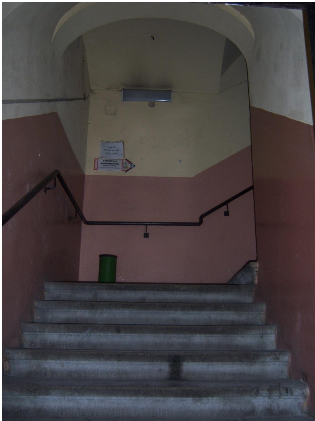
Klatka schodowa. Schody z lastryka, tynki malowane z olejną lamperią.
