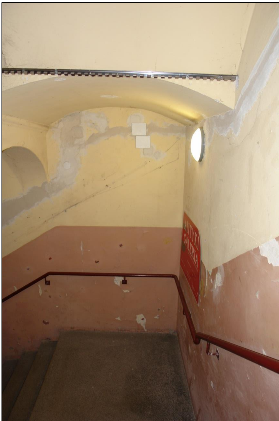
Klatka schodowa. Schody z lastryka, Widoczny pas malowanej farbą olejną lamperii.
