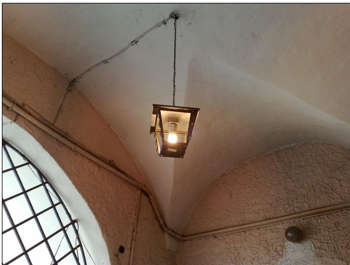
Sień przejazdowa – widoczne sklepienie oraz latarnia.
