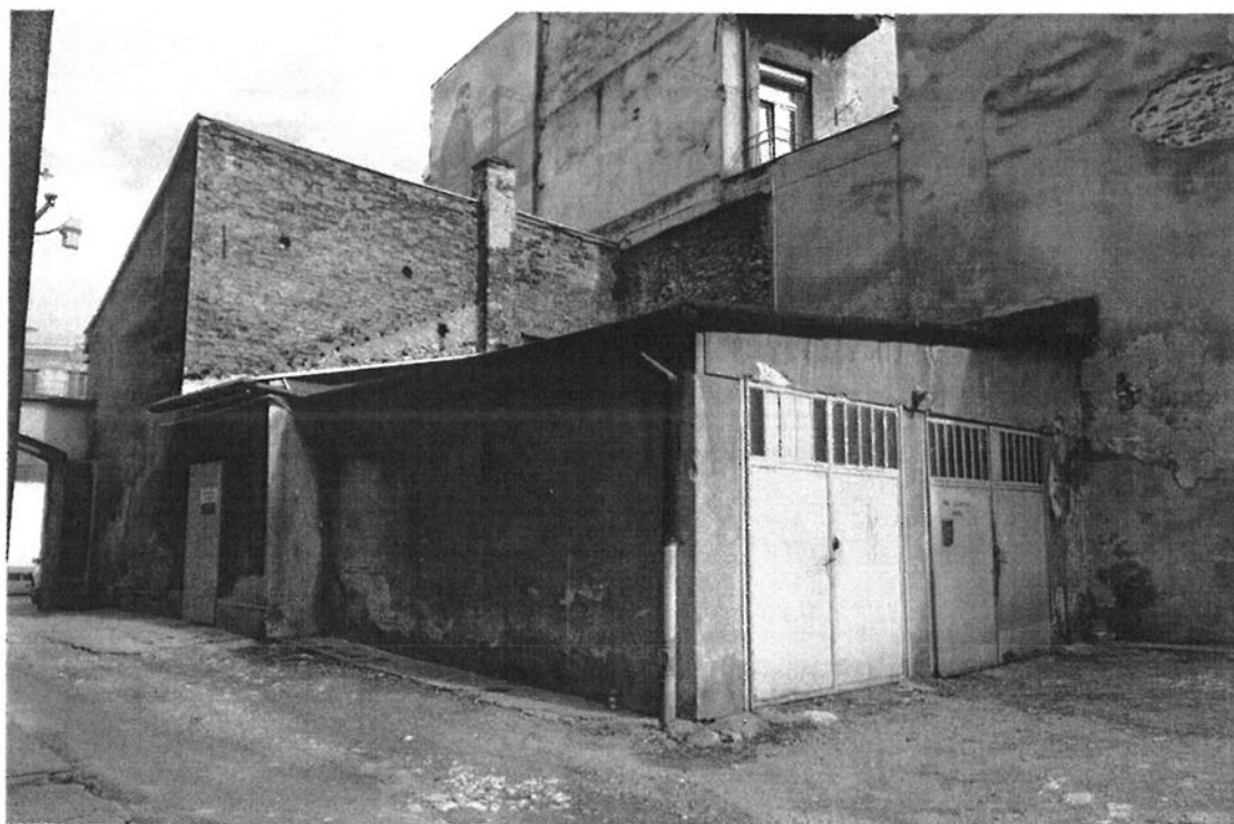
Fot.2. Budynek użytkowy, ul. B. Limanowskiego 34, Kraków. Elewacja tylna. Widok ogólny.
