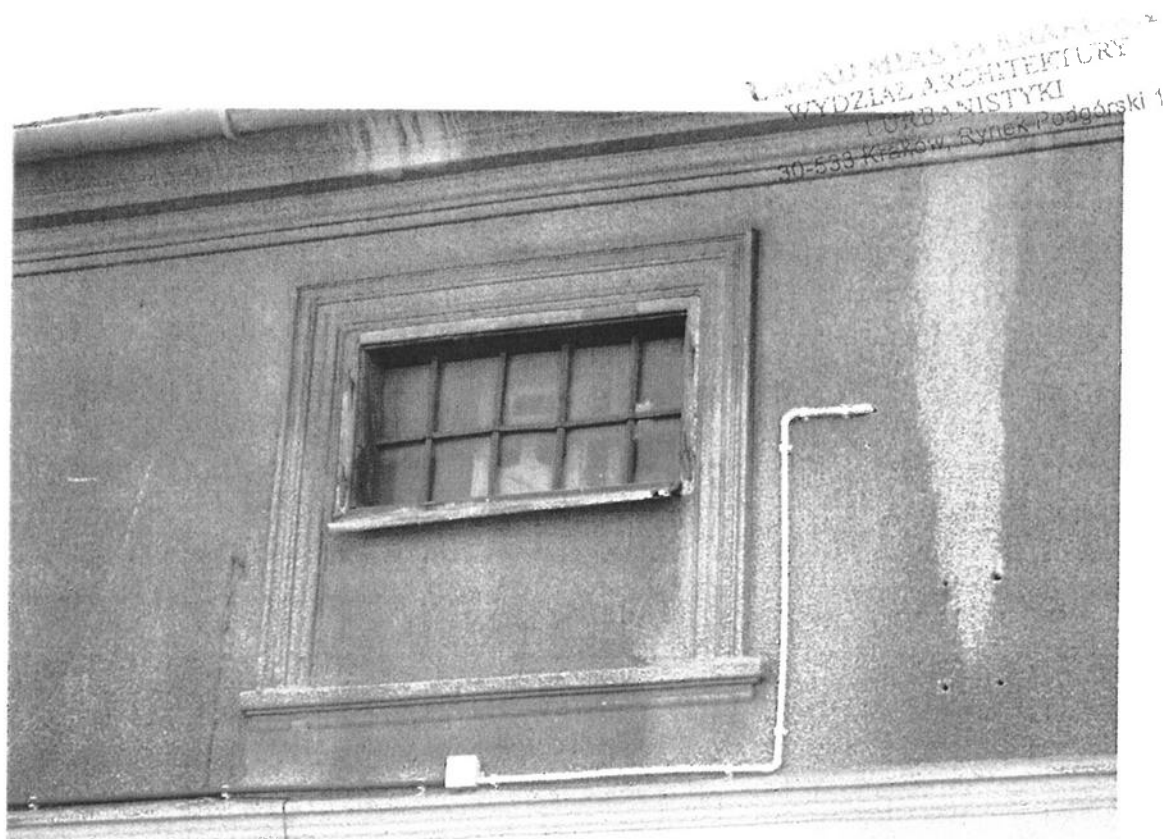
Fot.5. Budynek użytkowy, ul. B. Limanowskiego 34, Kraków. Elewacja frontowa. Fragment. Widoczne jedno z okien o ciekawej formie- w połowie zabudowane. Fot. Anna Frandlucha
