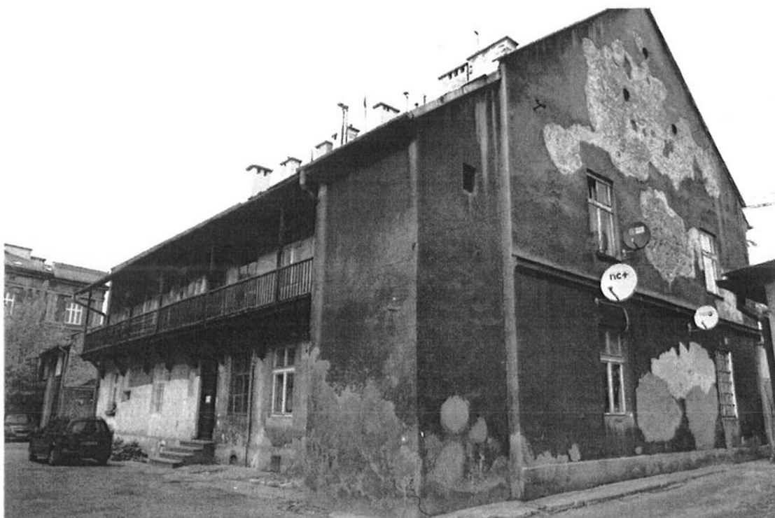
Fot.2. Budynek mieszkalny, ul. B. Limanowskiego 32, Kraków. Elewacja tylna oraz ściana wschodnia. Widok ogólny.
