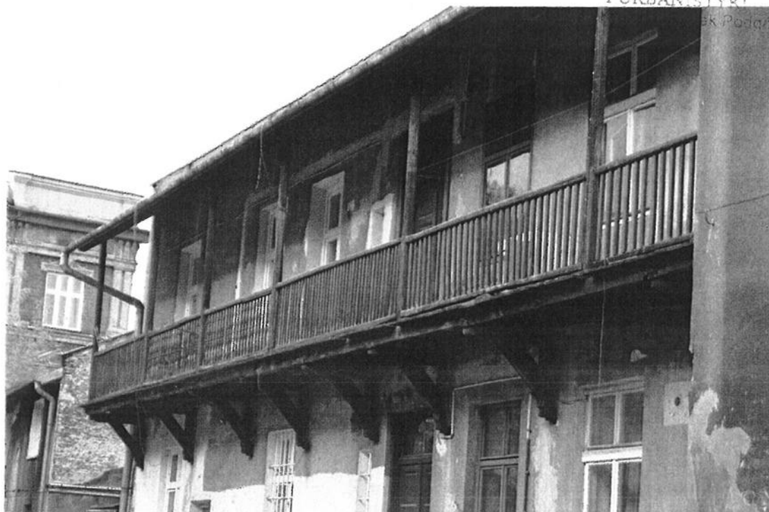
Fot.3. Budynek mieszkalny, ul. B. Limanowskiego 32, Kraków. Elewacja tylna. Fragment. Widoczna drewniana galeria.
