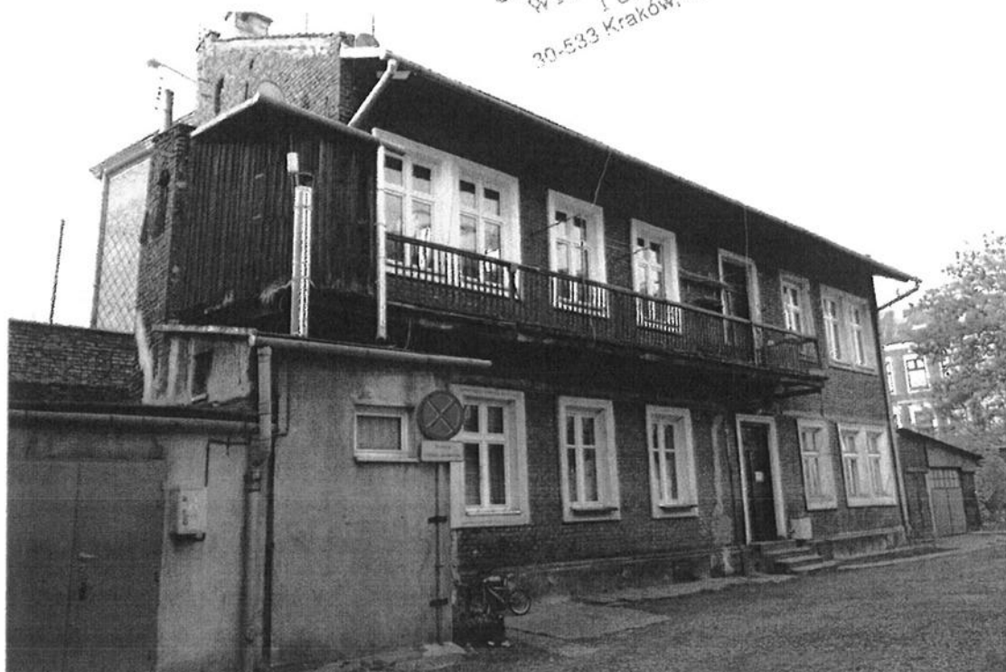
Fot.1. Oficyna tylna budynku przy ul. B. Limanowskiego 32. Elewacja frontowa. Widok ogólny.
