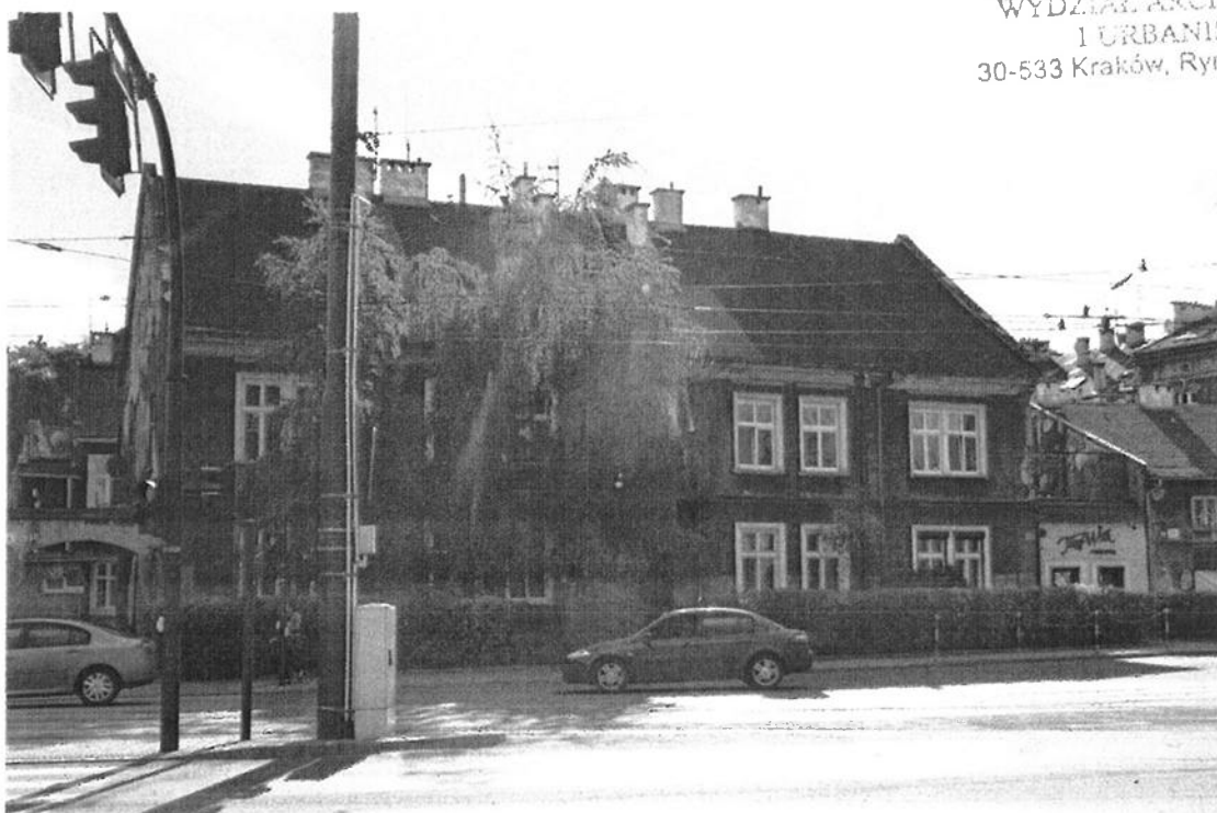
Fot.1. Budynek mieszkalny, ul. B. Limanowskiego 32, Kraków. Elewacja frontowa. Widok ogólny.
