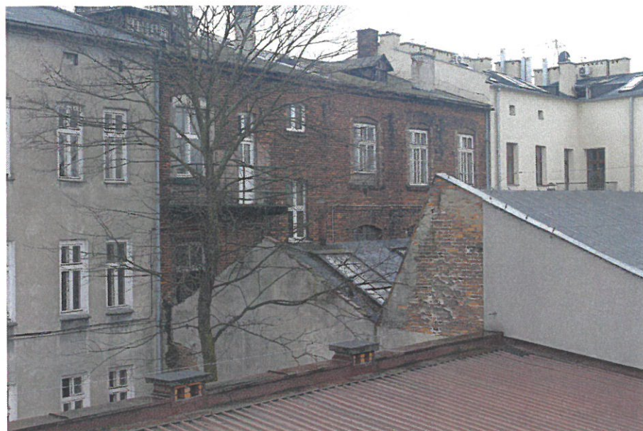
Fot. 3 Oficyna widziana od strony ul. Starowiślniej, widoczny dach budynku, a w tle kamienica przy ul. św. Wawrzyńca 26.
