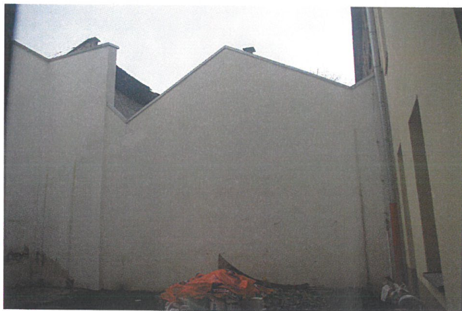
Fot. 2 Widok od strony zachodniej, z podwórka przy ul. Dajwór 18.
