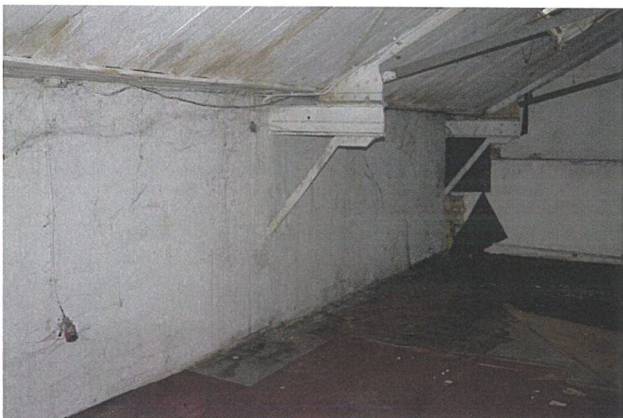
Fot. 12 Widok poddasza (ściana kamienicy przy ul. św. Wawrzyńca 26 - nie podlega ona rozbiórce).
