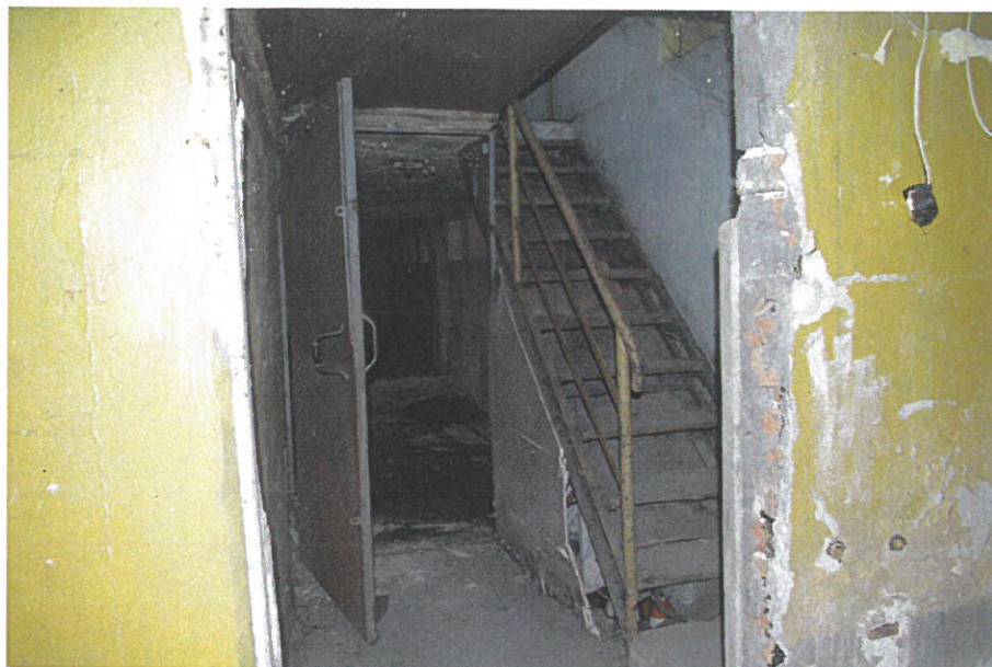
Fot. 9 Stalowe schody łączące kondygnację parteru z poddaszem.
