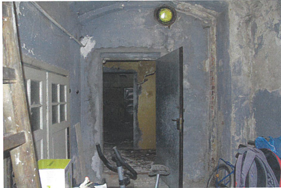
Fot. 7 Wejście do oficyny z kamienicy przy ul. św. Wawrzyńca, pomieszczenie na pierwszym planie, jako część kamienicy, nie podlega rozbiórce.
