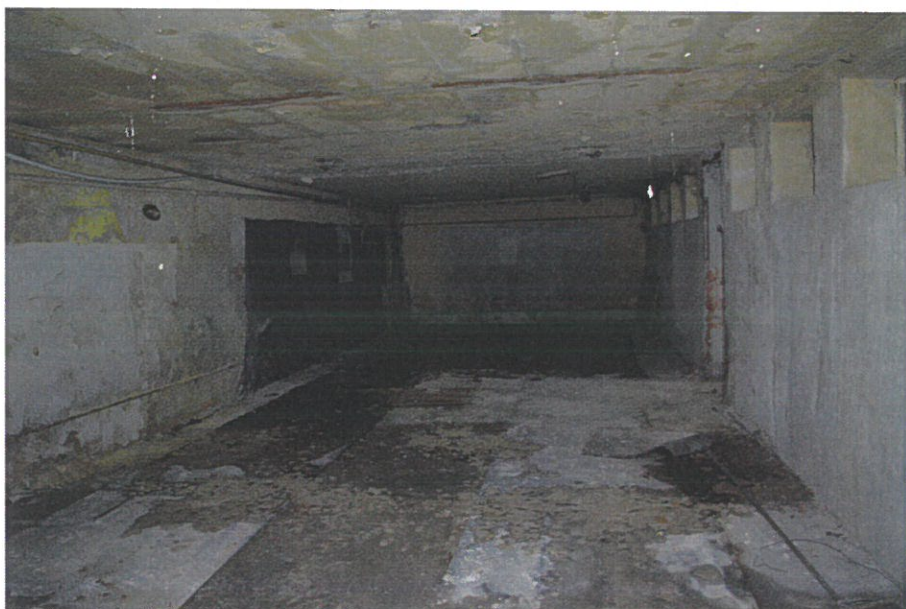
Fot. 10 Widok wnętrza oficyny, pomieszczenie przykryte żelbetowym stropem, po lewej stronie widoczna ściana (niepodlegająca rozbiórce) kamienicy przy ul. św. Wawrzyńca 26.
