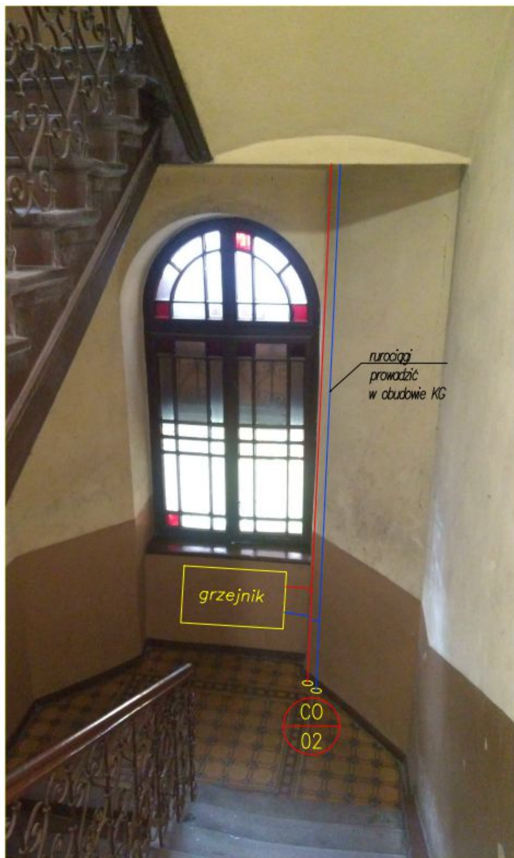
ZDJ. 1 Ul. Bożego Ciała 8 Budynek główny – półpiętro powtarzalne klatka schodowa
