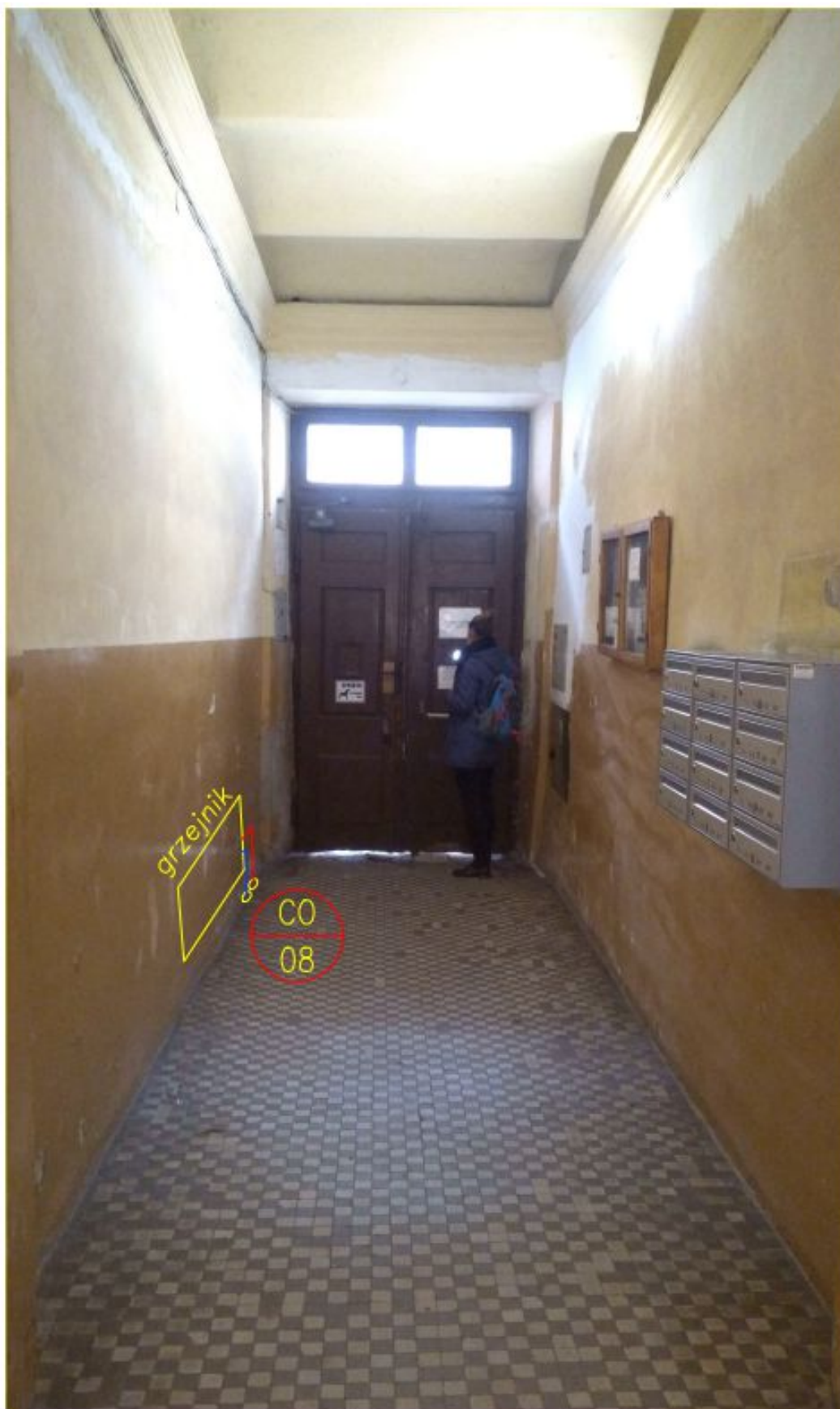
ZDJ. 4 Ul. Bożego Ciała 8 Budynek główny – klatka schodowa wejście do budynku od ul. Bożego Ciała
