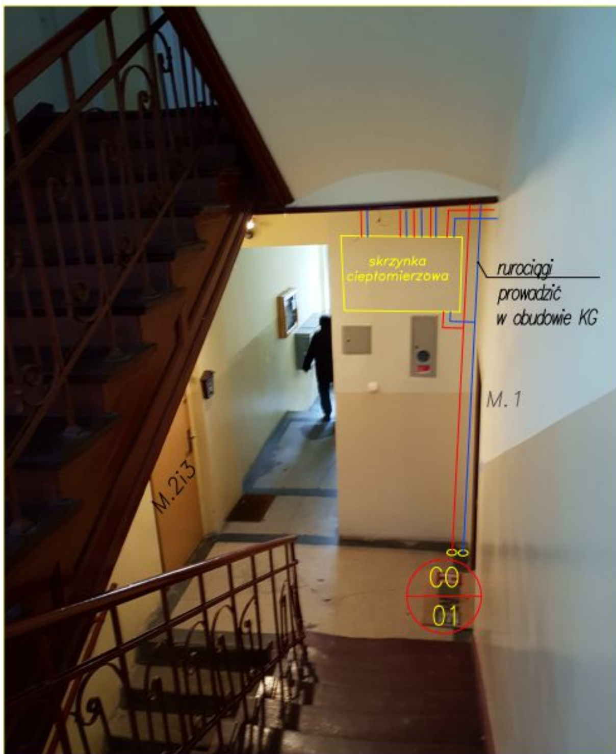
ZDJ. 2 Ul. Elizy Orzeszkowej 3 Budynek główny – parter klatka schodowa
