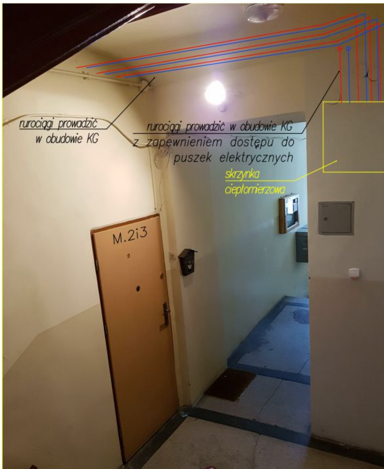
ZDJ. 3 Ul. Elizy Orzeszkowej 3 Budynek główny – parter klatka schodowa
