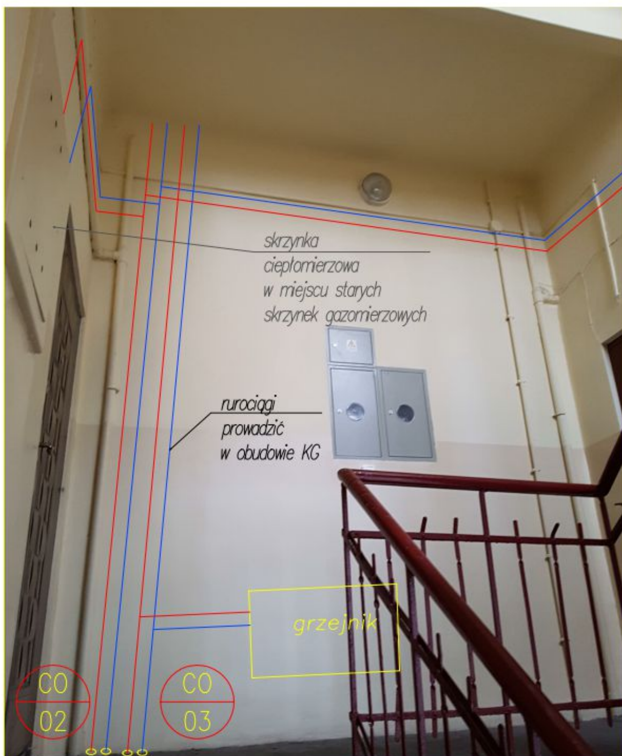
ZDJ. 7 Ul. Elizy Orzeszkowej 3 Budynek oficyny – piętro powtarzalne klatka schodowa
