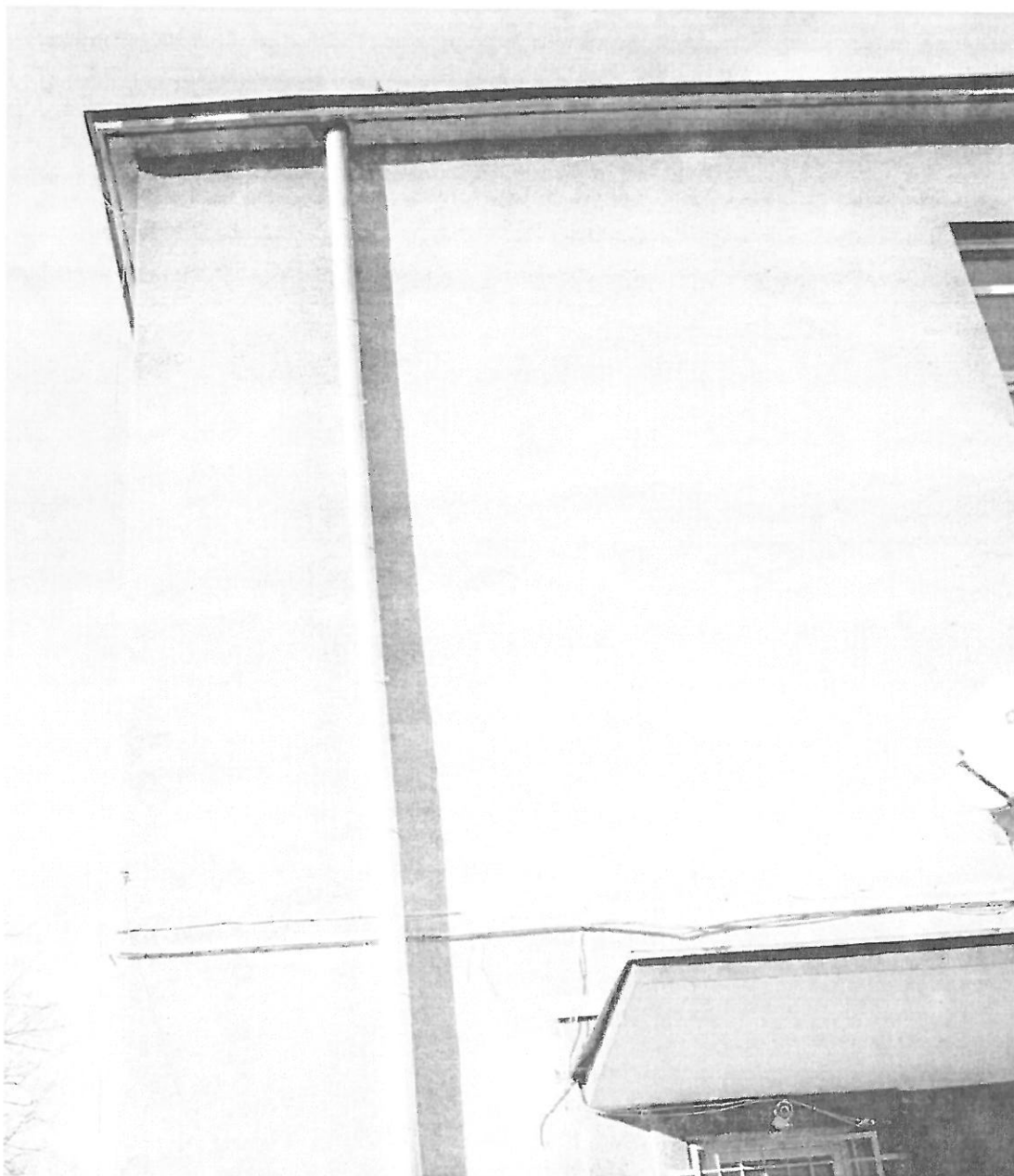
Fot. 6. Kraków, Na Kozłówce 29 – ściana północno-zachodnia budynku.. Szczeliny przy wejściu rury spustowej przez okap. Konieczne zamknięcie do końca lutego, by uniemożliwić zagnieżdżenie się ptaków.
