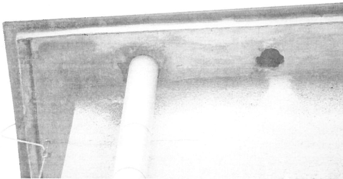
Fot. 5. Kraków, Na Kozłowie 29 – ściana południowo-wschodnia budynku. Otwór po rurze spustowej. Konieczne zamknięcie do końca lutego, by uniemożliwić zagnieżdżenie się ptaków.
