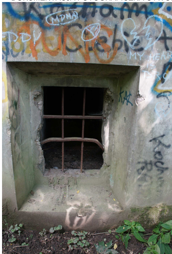
SCHRON GŁÓWNY – OTWÓR z wygiętą kratą
