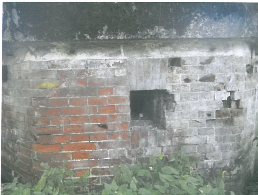
Fot. 70. Rozwarstwienia i ubytki cegieł w wątku ceglanym.
