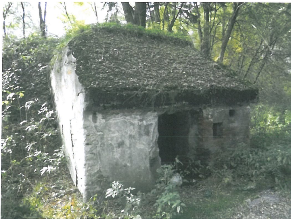
Fot. 69. Ostróg bramny – pierwotnie ceglany, obecnie częściowo pokryty tynkami.
