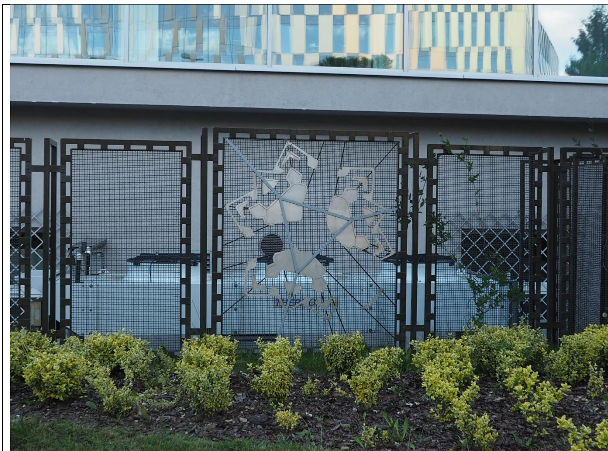
Ryc. 34. Treliż osłaniający chwyty powietrza dla budynku Wydziału Ochrony Środowiska w Ogrodzie Tadeusza Kościuszki. Połączenie funkcji ozdobnych, izolacyjnych i edukacyjnych. Motyw Twierdzy Czartorysk, zaprojektowanej przez Tadeusza Kościuskę
