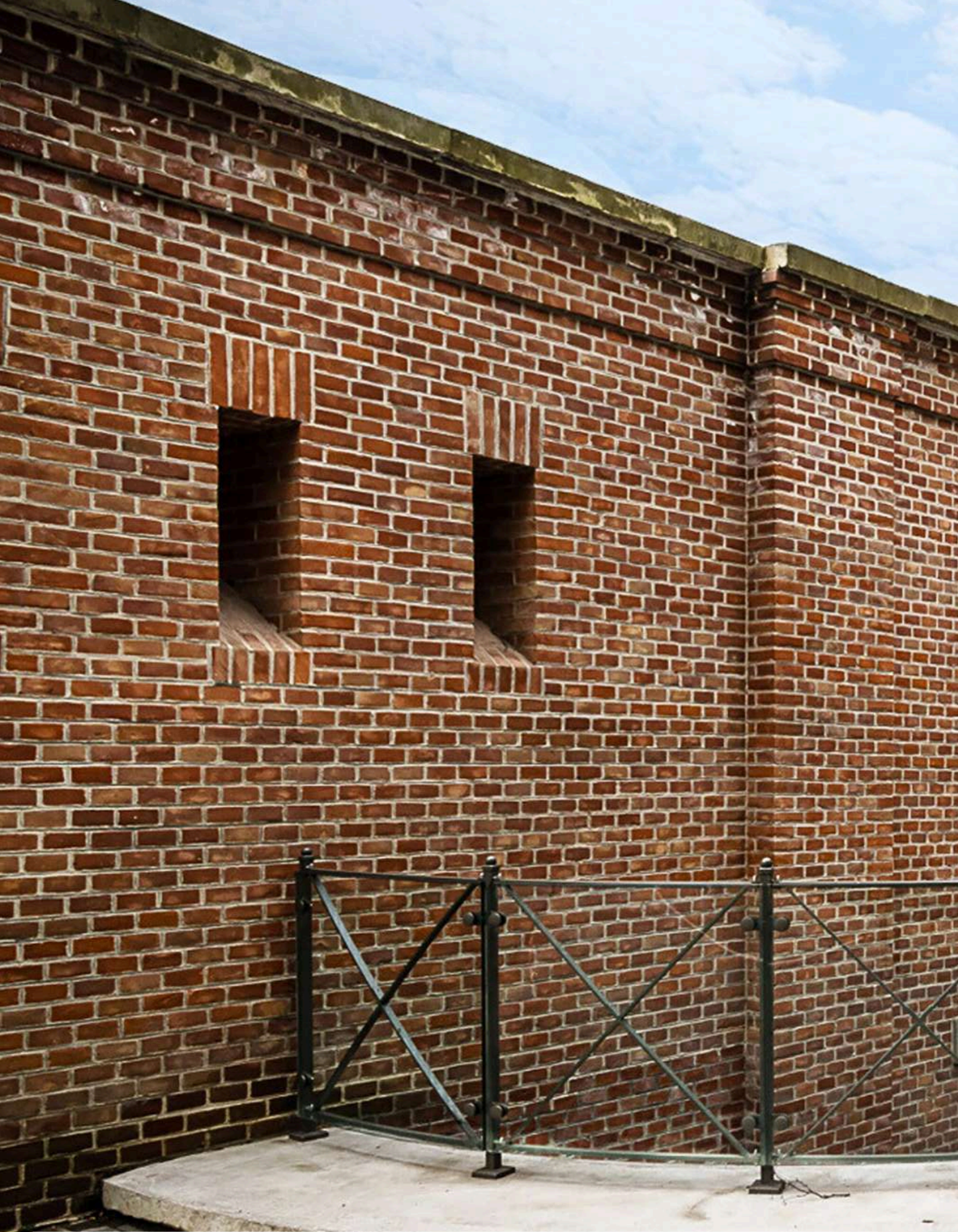
Elewacja wschodnia kaponiery zapola ze strzelnicą, pierwotnie dla mitraliezy Montigny M. 69, później dla karabinu maszynowego Schwarzlose M 7/12.
