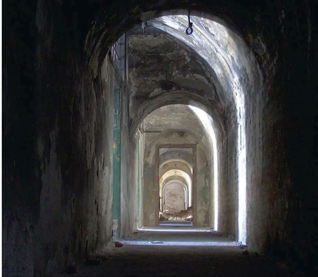
Korytarz koszar . Kondygnacja II.
