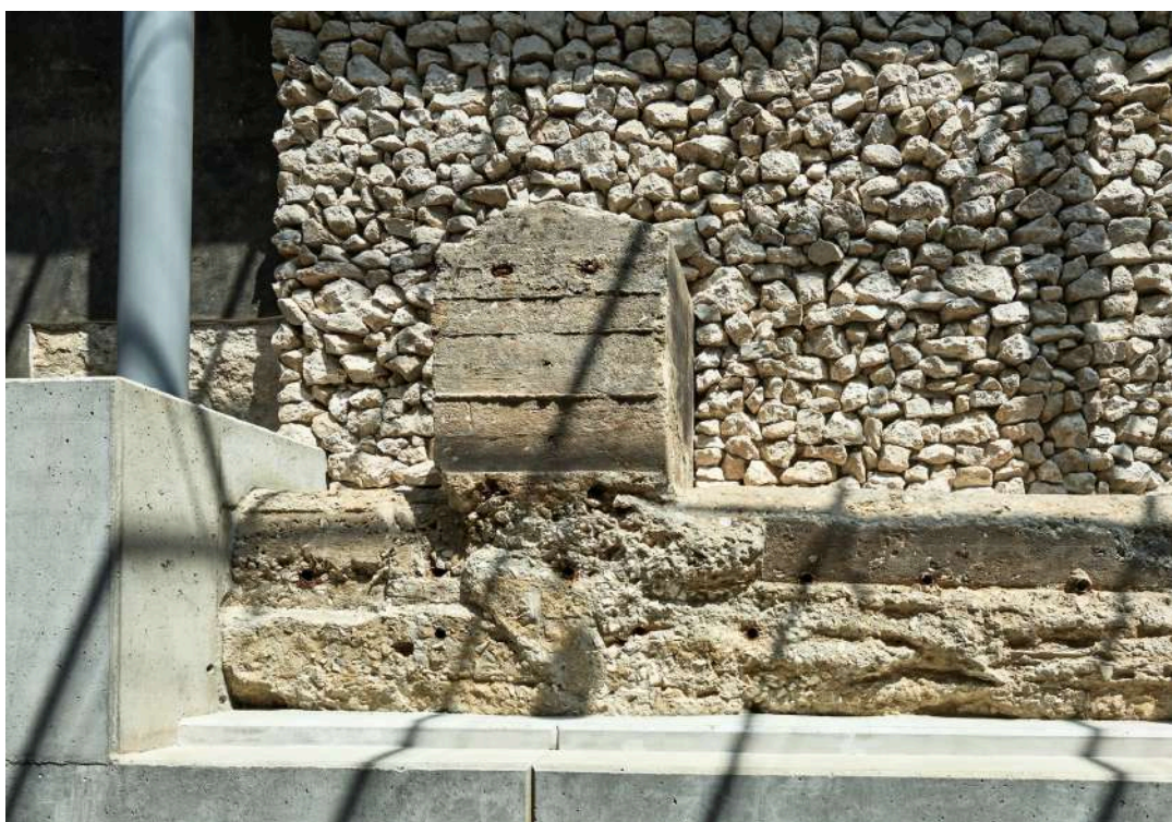
Fragment kanału odwadniającego łącznie z odtworzeniem fragmentu zasypu wraz z wejściem rewizyjnym
